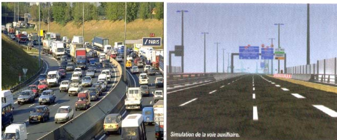
Figure 2 : Le tronçon commun A4-A86 (configuration à 4 voies avec BAU et simulation de la voie auxiliaire)
